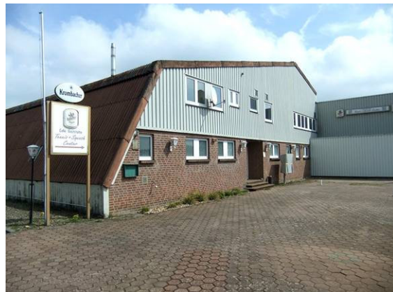
Der bestehende Gebäudekomplex an der Sportanlage bedarf einer Folgenutzung.
