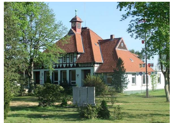
Das Baubild des Dorfgemeinschaftshauses sollte bei künftigen Sanierungen erhalten bleiben.
