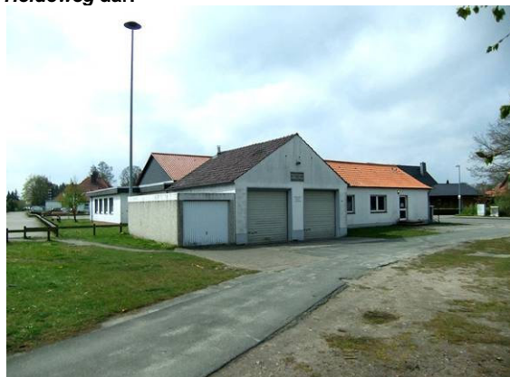
Handlungsbedarf im Ortskern mit altem Kalthaus und altem Feuerwehrgebäude.
