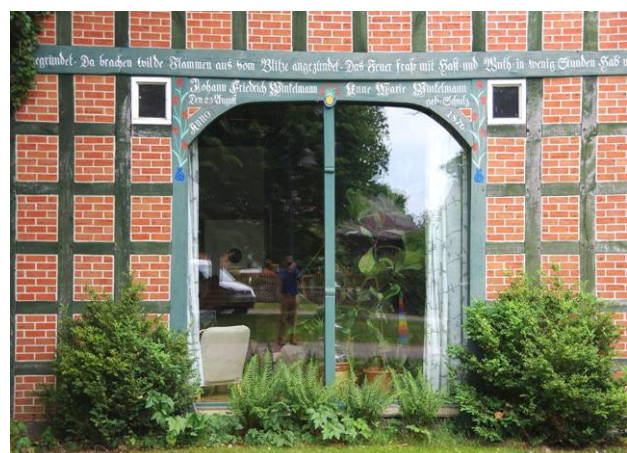
Beispiel für eine angepasste Modernisierung mittels großflächiger Fenster zur Beleuchtung im Innern.
