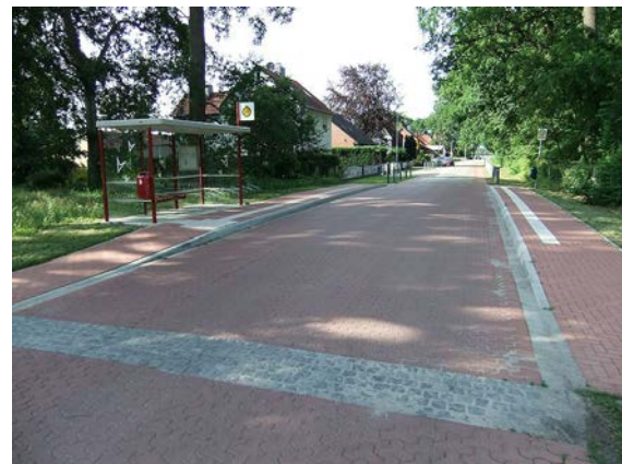
Barrierefrei zeigt sich dagegen die Haltestelle Alte Schulstraße in Stüde.
