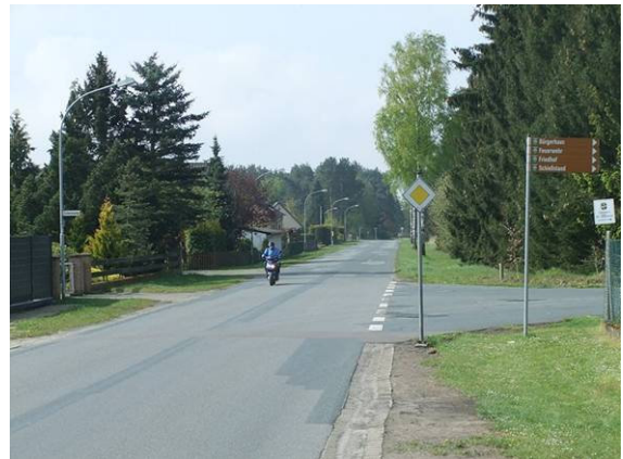
Die Seitenbereiche der K 30 sind unbefestigt - Fußgänger und Radfahrer müssen die Fahrbahn benutzen.
