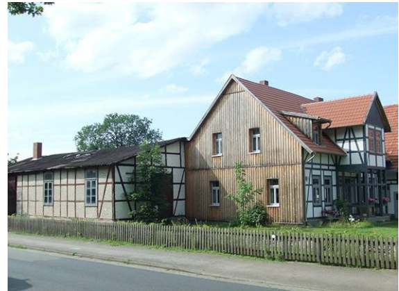
Bei der Sanierung des Wohnhauses wurden angepasste Baumaterialien gewählt.
