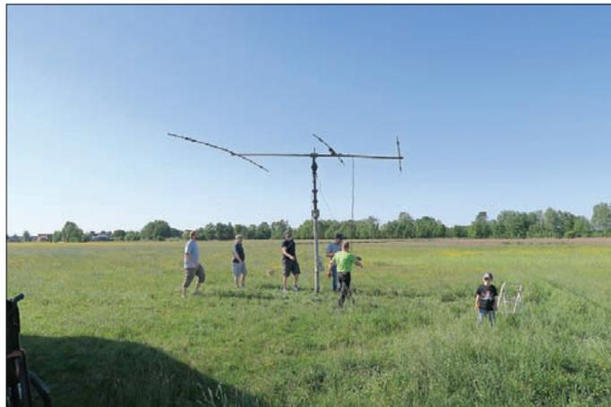
Ein Highlight war natürlich der gemeinsame Aufbau einer Kurzwellenrichtantenne auf einem zehn Meter langen Teleskop-Kurbelmast. Die mit einem Drehrotor versehene Antenne ermöglicht Verbindungen in jede gewünschte Himmelrichtung bis über den Horizont.
